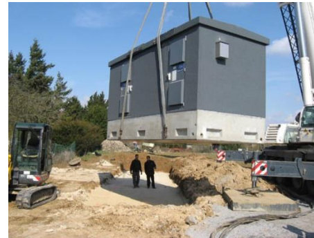
Photo 2 : Poste de livraison (brut) sur la centrale éolienne des Vingt Sétiers -28 (source : VOL-V, GAR © 2009 Double J Photos)
